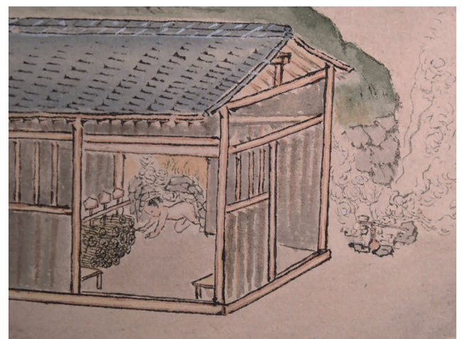
照湯温泉場部分 (蒸し湯と地獄釜)
