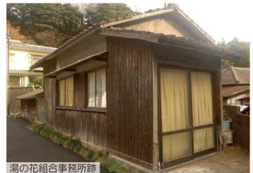
湯の花組合事務所跡 明礬温泉の噴気は酸性が強く、建物の建築部材も劣化が早くなるため、壁の取替が容易な板張り・鎧張りの建物が多くみられます。
