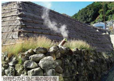
別府石の石垣と湯の花小屋 別府の地下に埋没する安山岩は、通称「別府石」と呼ばれ、この別府石の石垣と湯の花小屋の組み合わせは、明礬温泉の魅力の一つです。
