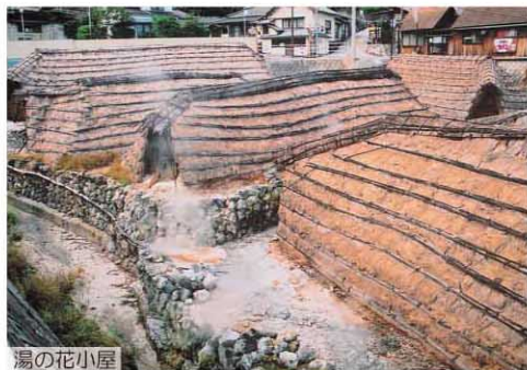
湯の花小屋 湯の花小屋は、酸性度の強い噴気の影響や地面に敷く青粘土の取替などで、2～3年ごとに建て替えられています。
