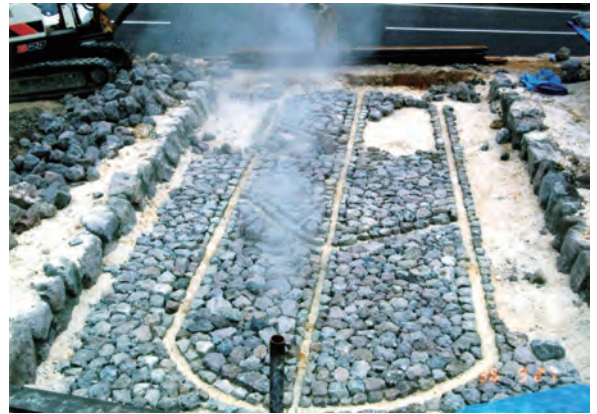
写真6.2.2 硫気溝を小石でつくる「床作り」
