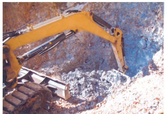
写真6.2.4 青粘土の掘り出し
