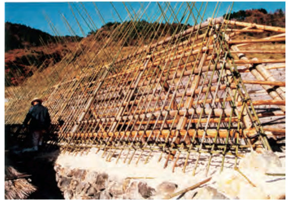
写真6.2.3 湯の花小屋の柱と垂木組
