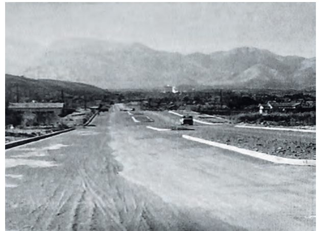
写真8. 1. 22 開通直前の横断道路
