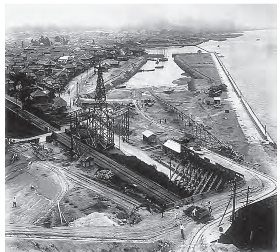
写真8.1.15 埋立地の工事
