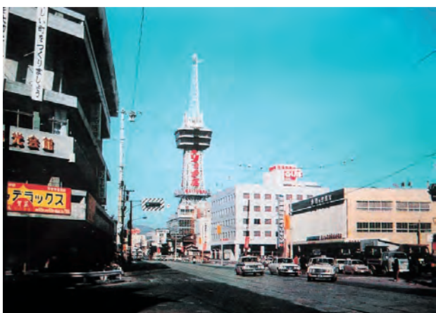
写真8.1.20 開業間もない頃（1965年頃）の別府タワー
