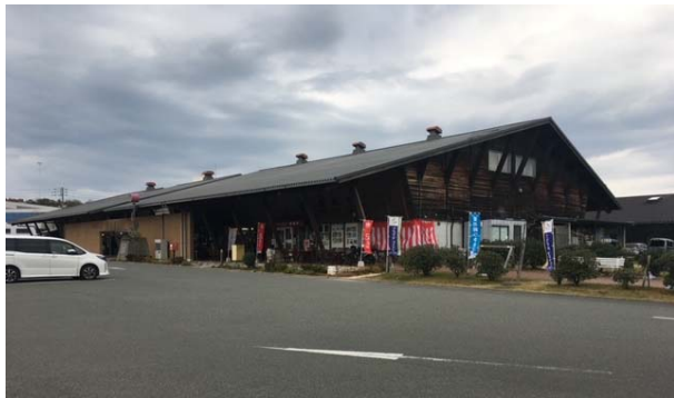
道の駅 萩しーまーと(外観)
