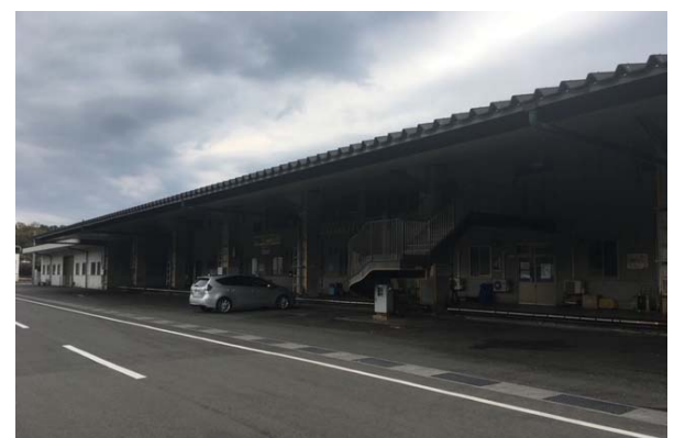
萩地方卸売市場(外観)
