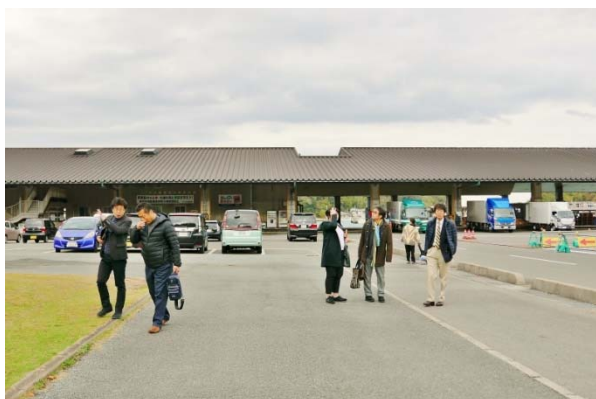
萩地方卸売市場(外観)
