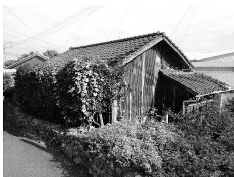
外壁剥落・瓦落下
