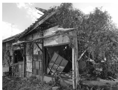
構造材損傷・屋根材剥落・外壁剥落
