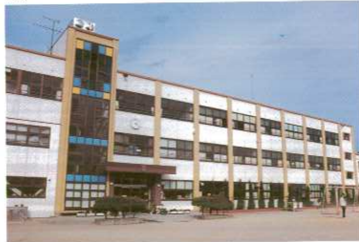
大規模耐震補強工事を行った亀川小学校校舎 各学校を計画的に耐震補強工事を進めています。
