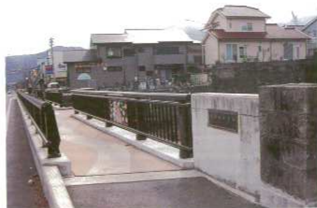
▲通学路の安全を確保するために歩道橋の設置を進めています。
